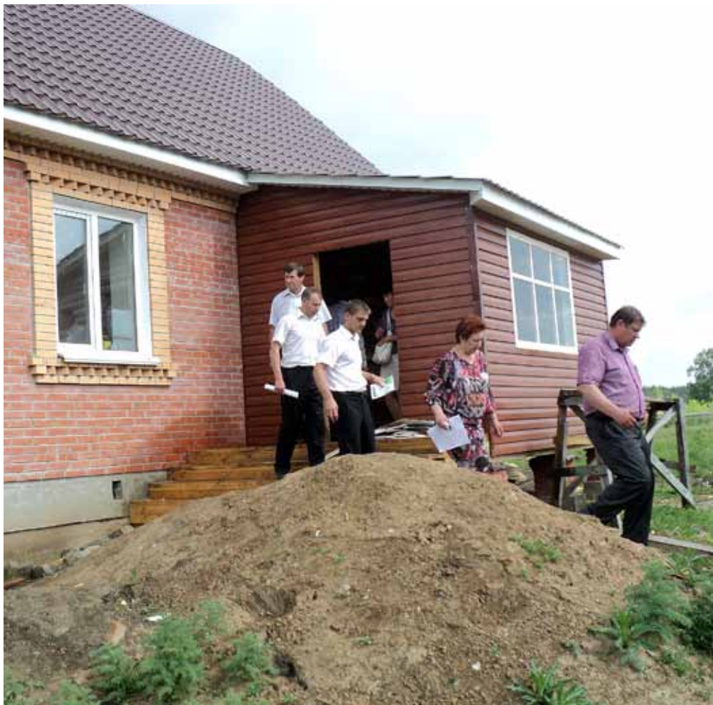
■ Под компактную застройку для специалистов села выделено 20 участков около в д. Феоктистовка. 7 домов уже готовы, еще на 7-ми участках залиты фундаменты.
